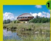
17 Ecopôle du Forez 42110 Chambéon 04 77 27 86 40 www.frapna.org/loire
