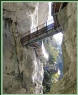
Passerelle de la grotte inférieure
